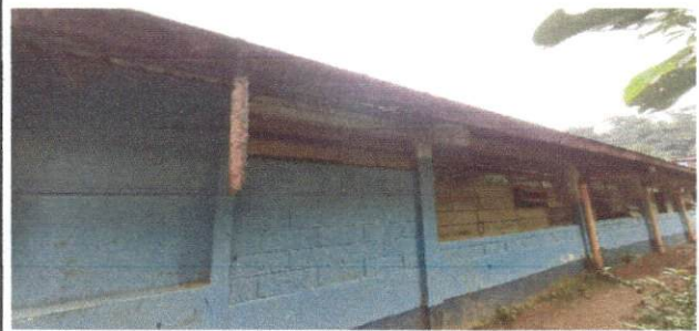
Foto 10: Sustitución de canales de metal.
