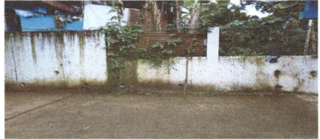
Foto 8: Reparación de muro perimetral de block.
