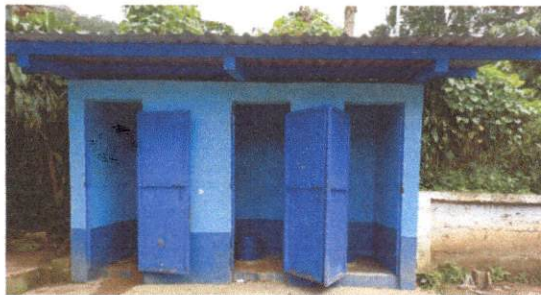
Foto 11: Sustitución de azulejo
