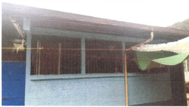
Foto 9: Sustitución de canales de metal.
